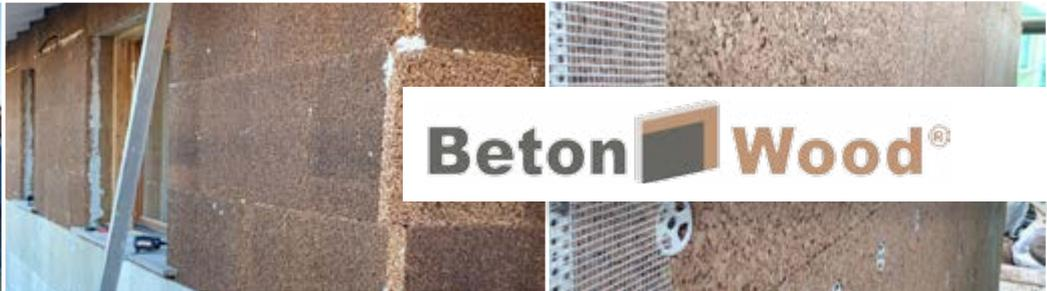
Oltre all'incollaggio con un legante minerale ed alla malta di rinforzo, il pannello intonacabile **Cork Panels L** deve essere fissato con i nostri tasselli ad espansione; dei quali forniamo uno schema di posizionamento associato al tipo di pannello.
